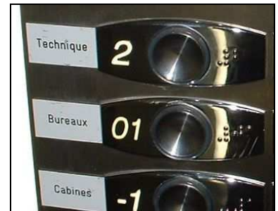
Boutons de commande avec inscription en braille et voyant lumineux.
