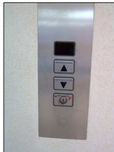
Boutons d'appel munis de voyants lumineux et de flèches en relief.
